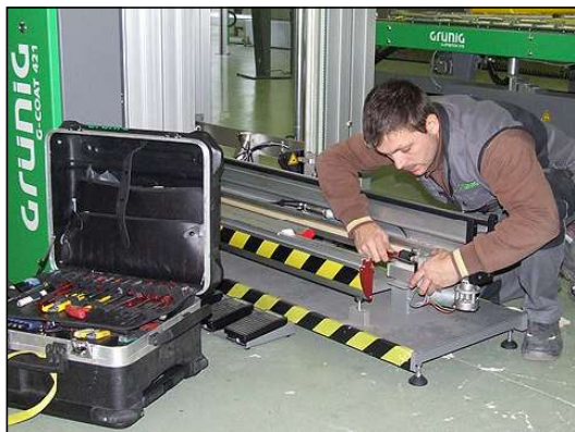
Installation / Inbetriebnahme & Einschulung
