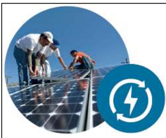
Energie -Brennstoffzellen u. erneuerbare Energien
